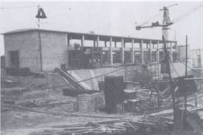
Richtfest beim Kraftwerk / Staustufe Intschede 1957 Foto: Helga Schmidt, Einste
